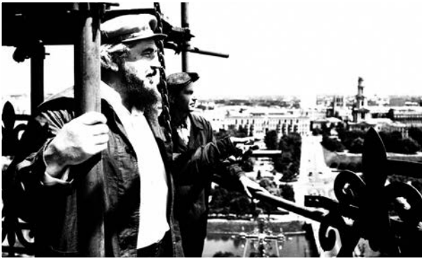
Во время проведения кровельных работ на куполах Свято-Благовещенского собора
